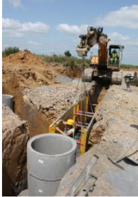
Gestion eaux pluviales
