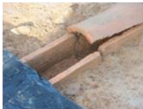
tuiles en forme de U et de pierres de calage recouvertes de tuiles rondes
