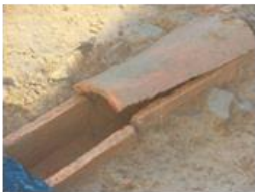
tuiles en forme de U et de pierres de calage recouvertes de tuiles rondes
